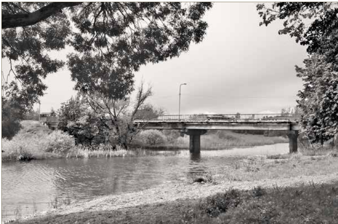
Мост через реку Каменку. Построен в 1972 г.
