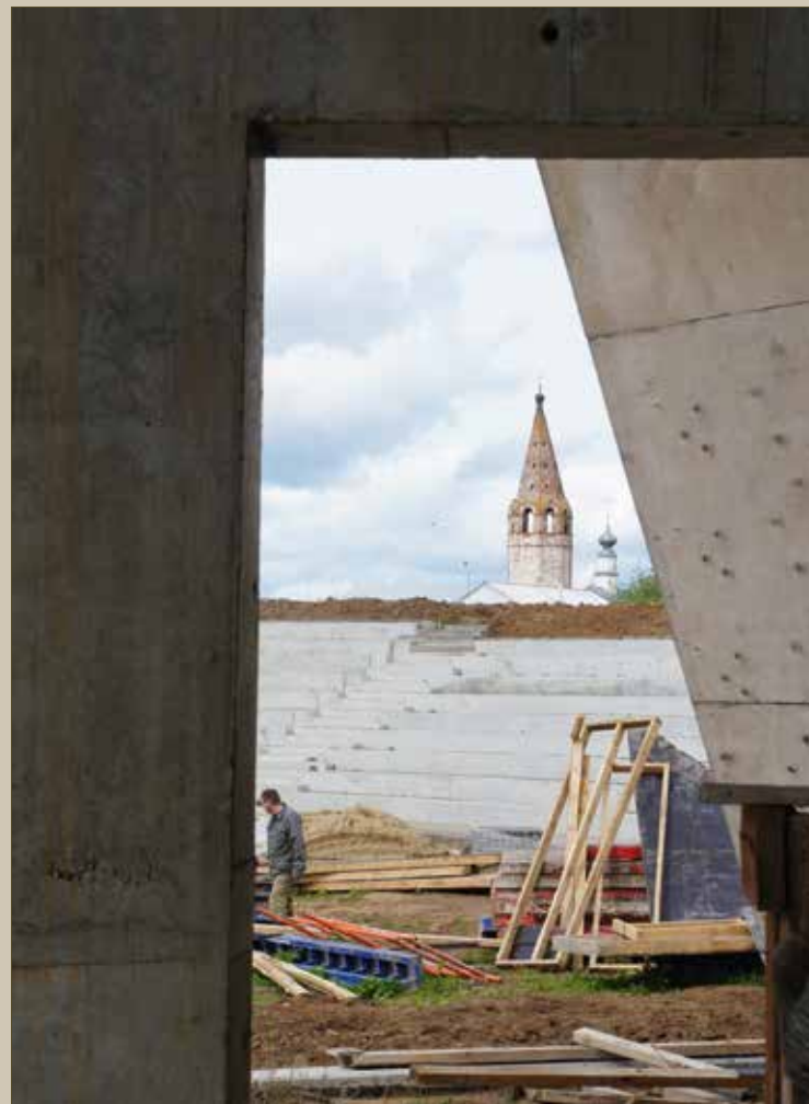
Суздаль. ГТК. Новая стройка. Фото В. Радзиевского. 2017
