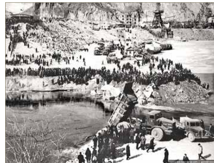
На строительстве Красноярской ГЭС. Енисей перекрыт. 25 марта 1963 года
